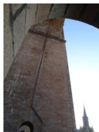
Une arche du viaduc
