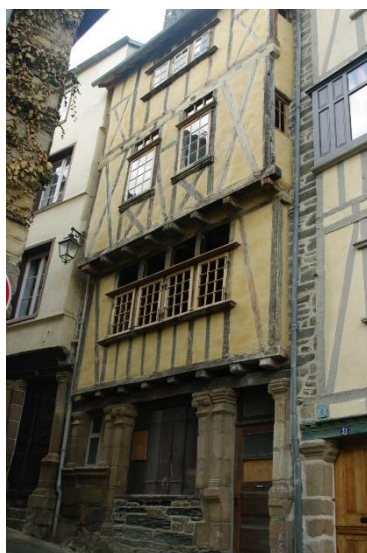
Façade plan à pièce unique à pan de bois apparent– 33, rue longue
