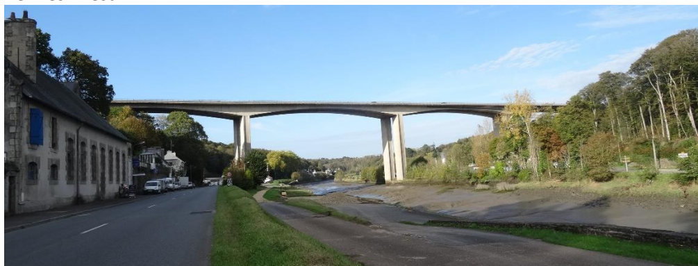
Figure 29 : Pont routier construit en 1970, Source : MM 2014
